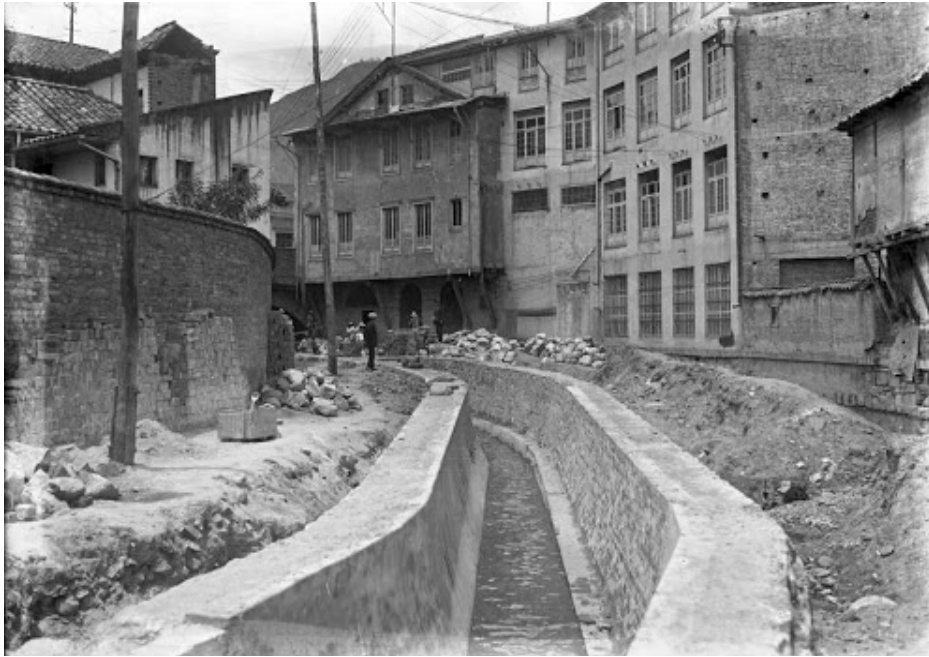
Cobertura Río San Francisco
