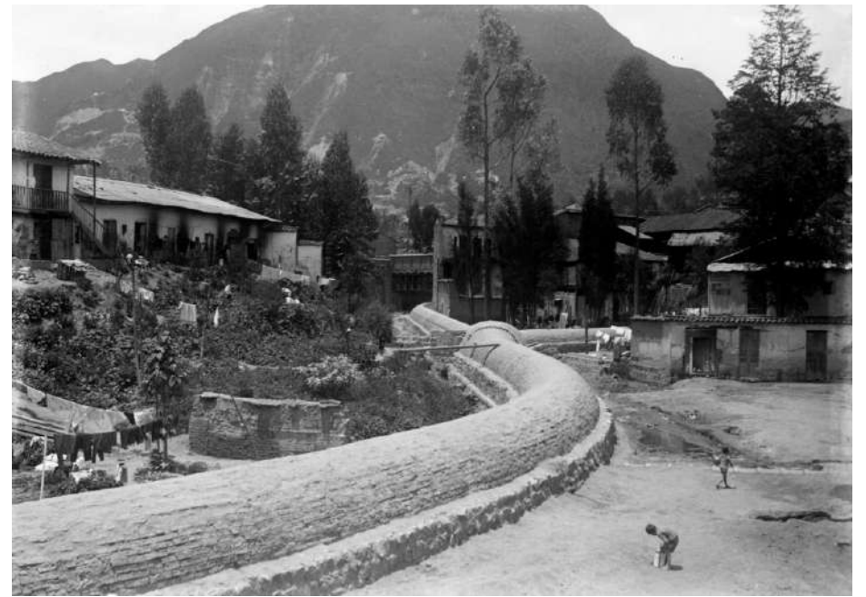
Cobertura Río San Francisco
