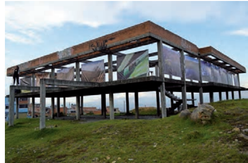
Overview of the intervention in "El esqueleto" | Vista general de la intervención en "El esqueleto"
